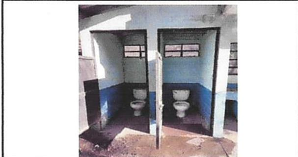
Foto1: Reparación de baños lavables, (cambio de sanitarios y accesorios, pintura y mantenimiento de puertas
